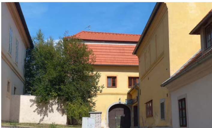
▲ budova čp. 108, současné obecní byty a KCMT
