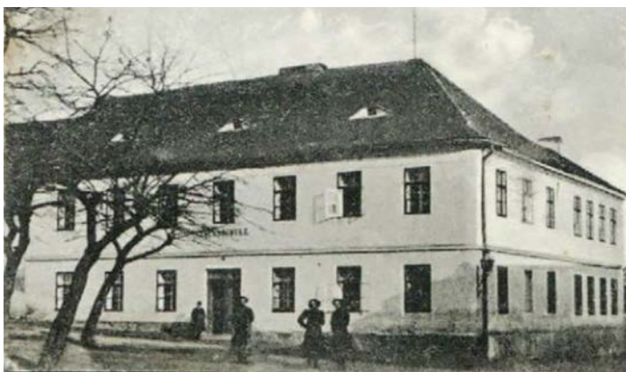
▲ dům čp. 115 v Kostelní ulici
