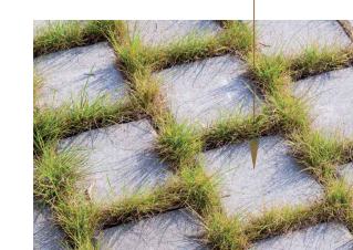
ZATRAVŇOVACÍ DLAŽBA PARKOVANÍ
